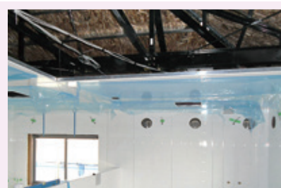
⑨ 天井パネル組立
