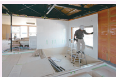
⑤ 壁パネルの組立
