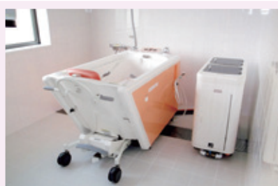
⑭ 機械浴槽搬入&据付(材工別途)
