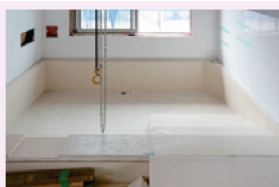
⑧ 浴槽据付
