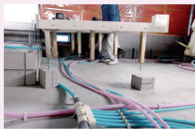
② 防水パン据付
