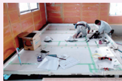
③ 防水パン分割部接続&レベル調整
