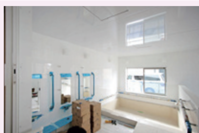
⑪ 本体主要部分の組立完了
