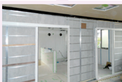
⑦ ドア枠と壁パネル(脱衣所側から)
