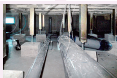
④ 給排水管の接続
